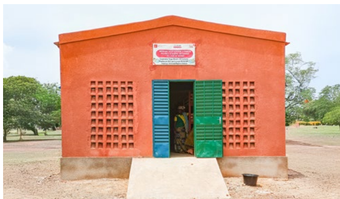
10 Magasins de stockage d'oignon d'une capacité de stockage de 50 tonnes chacun construits
