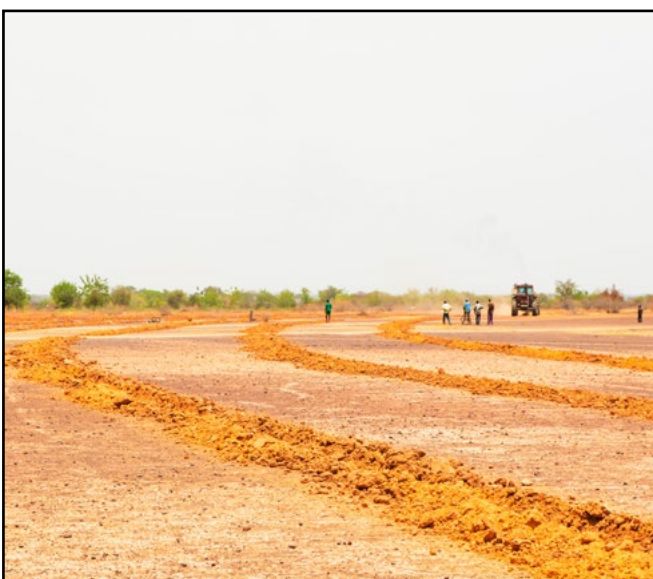
Réalisation des tranchées sur la terre inculte par la charrue Delfino
